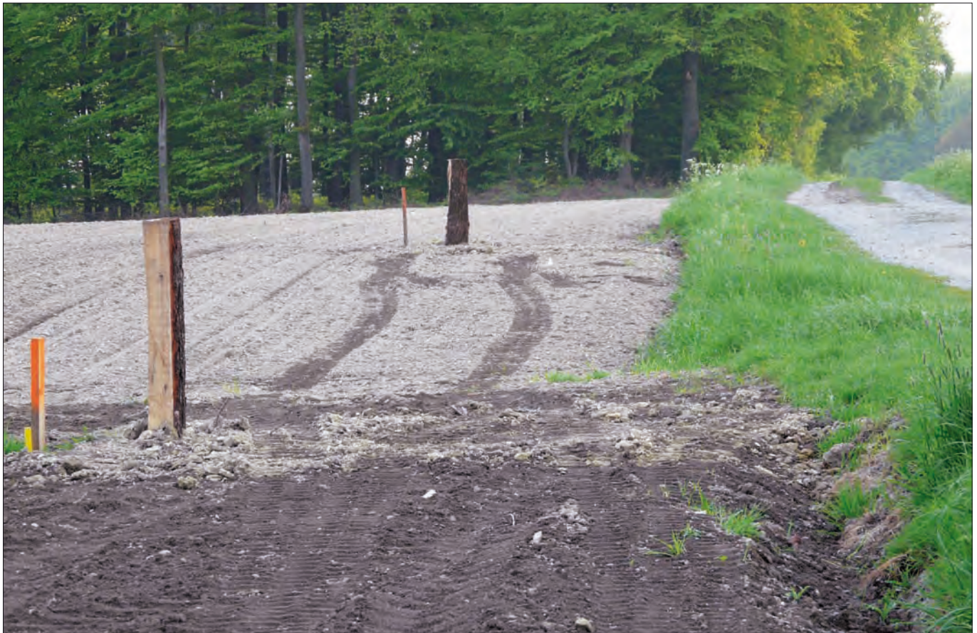
Wiederherstellung der ursprünglichen Wegrainbreite und Markierung mit Eichenspaltpfählen
